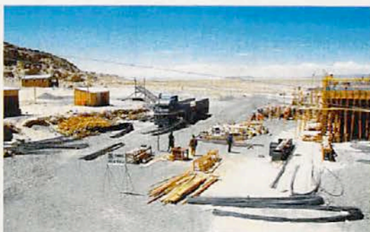
② リチウムを取り出す実験施設の建設
